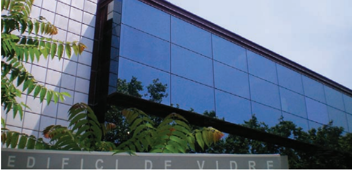
L'Edifici de Vidre acull les instal·lacions d'Almir
